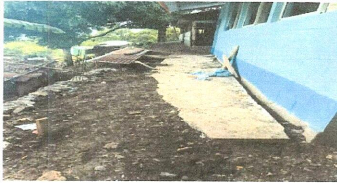
Foto1: Módulo 10, muro de contención
