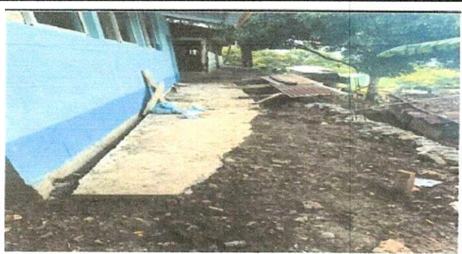
Foto 4: Módulo 10, muro de contención
